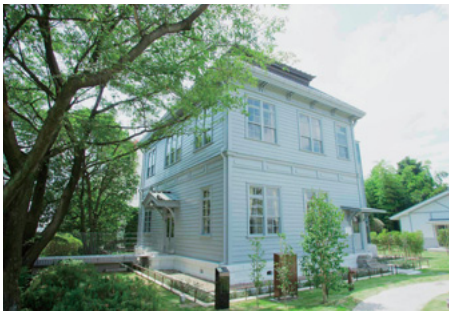
製粉ミュージアム本館
