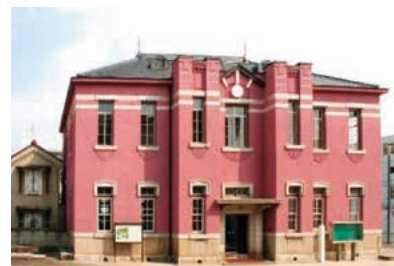
旧模範工場桐生燃糸合資会社事務所棟
