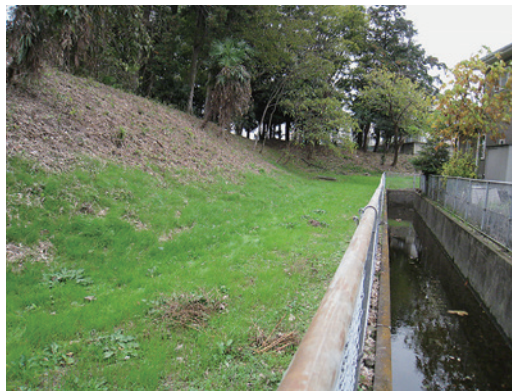
第一中学校北側の総構え(土塁と堀)
