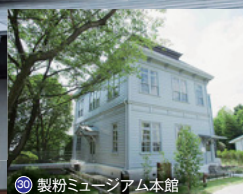
30 製粉ミュージアム本館
